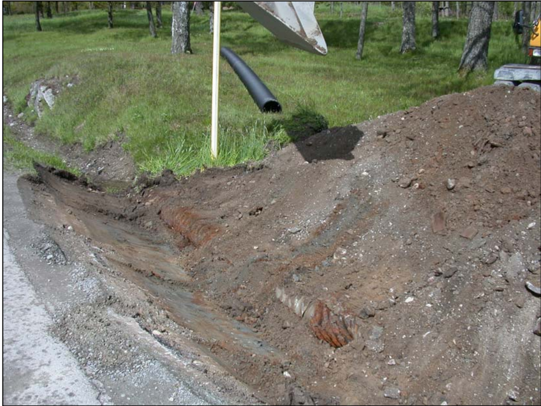
Figur 5. Grävning i den sydligaste vägen. Den tidigare trumman av järn syns tydligt. Foto av Björn Wallbom.
