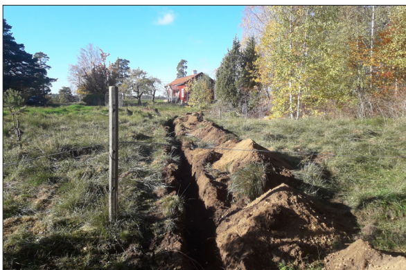
Figur 11. Schakt 1279, Ytterselö 123:1. Bilden är tagen från öst. Foto: Ingeborg Svensson 2018, Sörmlands Arkeologi AB.
