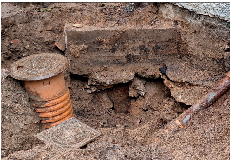
Schakt 1 med 1930-talets grundförstärkning och delar av pålningen synlig. Foto mot sydost: Lars Norberg 2022, Sörmlands Arkeologi AB.
