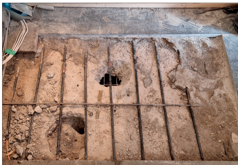
Schakt 2 i samband med undersökning av golvet. Två titthål bilades i den underliggande betongsulan. Notera tätt lagda ledningar med golvvärme. Foto mot nordnordväst: Lars Norberg 2022, Sörmlands Arkeologi AB.
