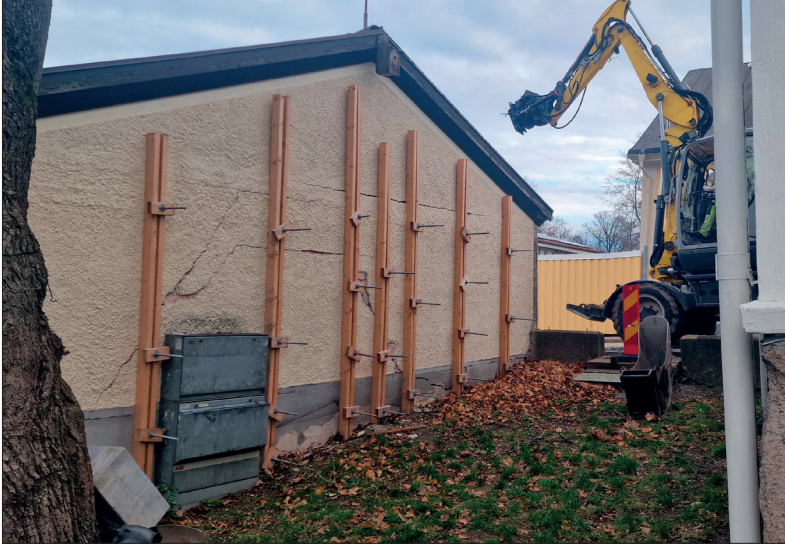
Undersökningsområdet före schaktning. Foto mot nordost: Lars Norberg 2024, Sörmlands Arkeologi AB.
