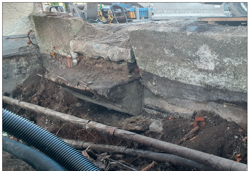
Betongstöd & ledningar i schaktets nordvästra del, det vill säga mot Behmbrogatan. Foto: Patrik Gillbrand 2024, Sörmlands Arkeologi AB.
