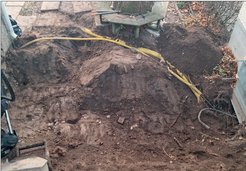
Den sydvästra delen av schaktet i samband schaktning. Foto: Lars Norberg 2024, Sörmlands Arkeologi AB.
