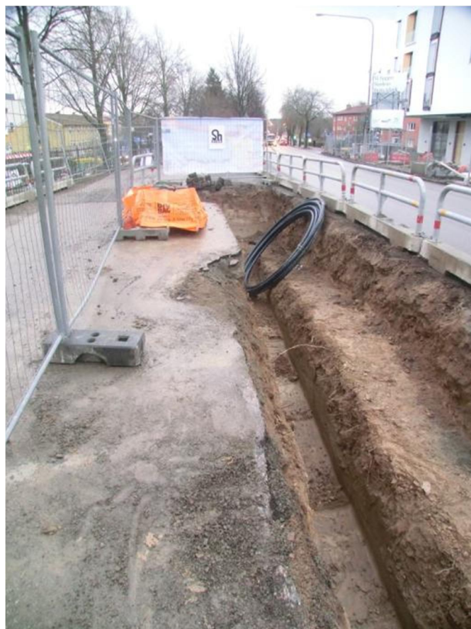
Figur 3. Södra delen av schaktet. Foto mot söder 2013-12-12, Bent Syse, Upplandsmuseet.
