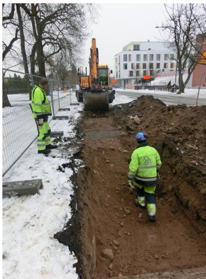
Figur 4. Norra delen av schaktet. Närmast i bild syns kulverten och lite längre fram nedgrävningen för den korsande fjärrvärmeledningen. Foto mot söder 2013-12-10, Bent Syse, Upplandsmuseet.
