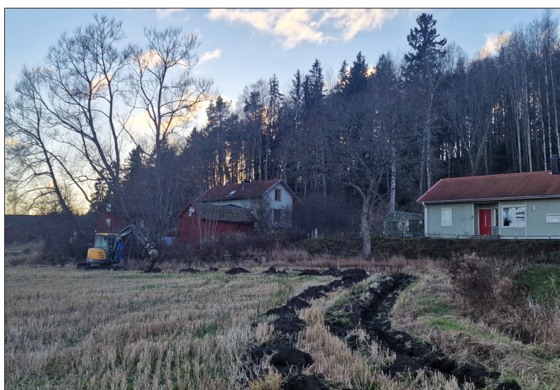
Del av fiberschakt S6239 i anslutning till Trosa by inom fornlämning L1983:4662. I bakgrunden syns Trosa Lands kyrka. Foto mot sydväst: Lars Norberg 2022, Sörmlands Arkeologi AB.
