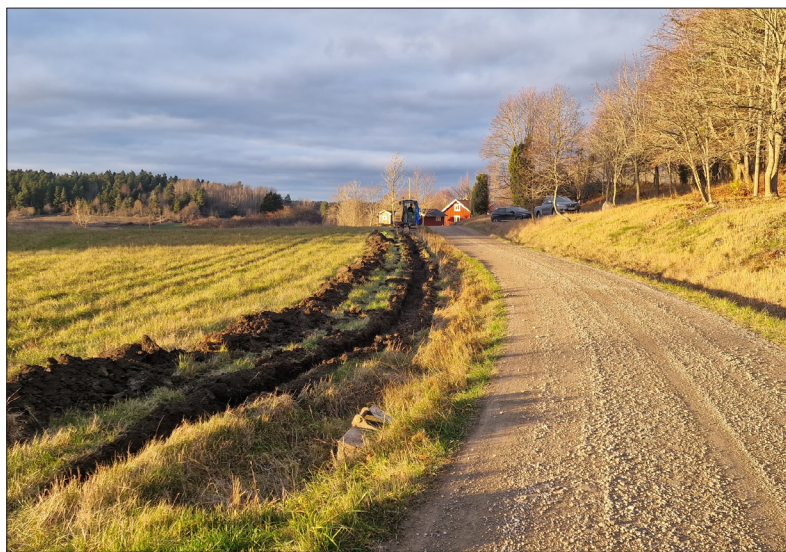
Del av fiberschakt i S6184 anslutning till Berga. Fornlämningarna L1984:8116, L1984:8016 & L1984:8017 är belägna i backen till höger i bild. Den nypåträffade härden påträffades i schaktet till vänster (A6176/L2023:321). Foto mot norr: Lars Norberg 2022, Sörmlands Arkeologi AB.
