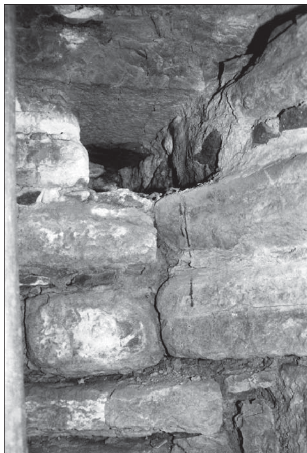
Figur 6. Kanalen i kalkstensmurverket mellan brunnsmurningen och södra väggen.
