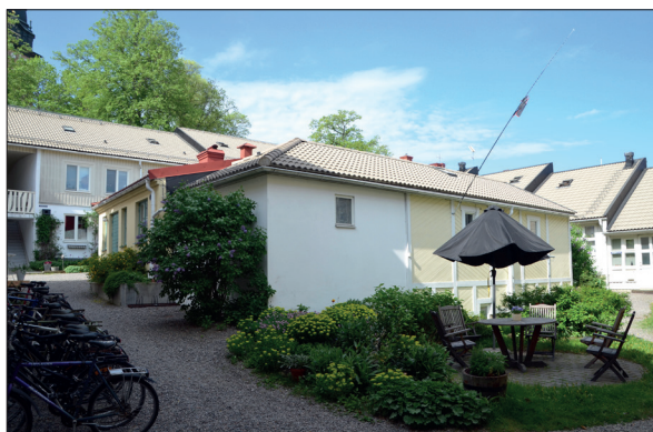
Gårdshusets norra långsida fotograferad före schaktning mot sydväst. Foto: Lars Norberg 2018, Sörmlands Arkeologi AB.
