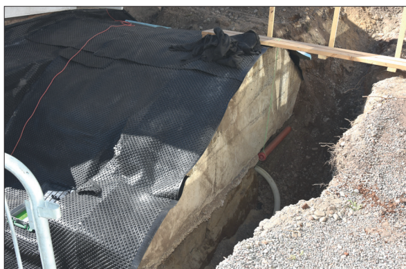
Dräneringsschaktet i väster, invid tunnvalvet. Notera betongförstärkningen. Foto: Lars Norberg 2018, Sörmlands Arkeologi AB.
