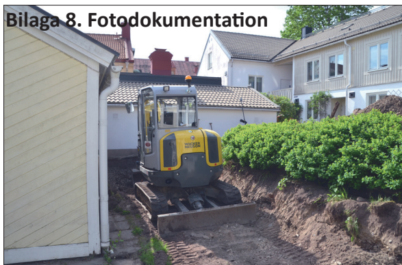
Inledande schaktning för dränering söder om gårdshuset. Foto mot sydost: Lars Norberg 2018, Sörmlands Arkeologi AB.
