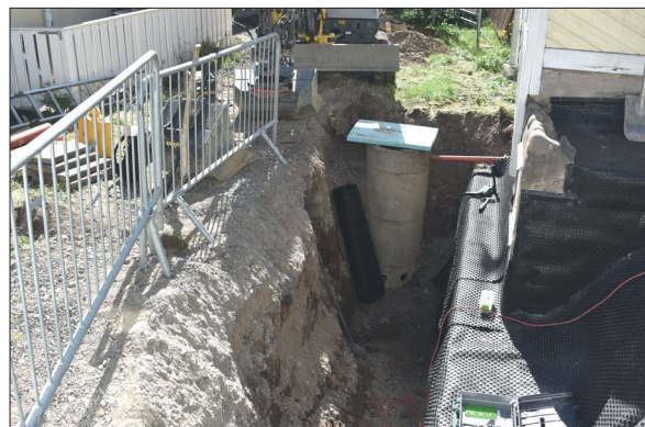
Schaktet norr om gårdshuset. I bakgrunden befintlig vertikal brunn. Foto mot sydost: Lars Norberg 2018, Sörmlands Arkeologi AB.
