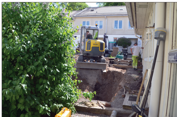
Schaktning för dränering väster om gårdshus och valv. Foto mot sydväst: Lars Norberg 2018, Sörmlands Arkeologi AB.
