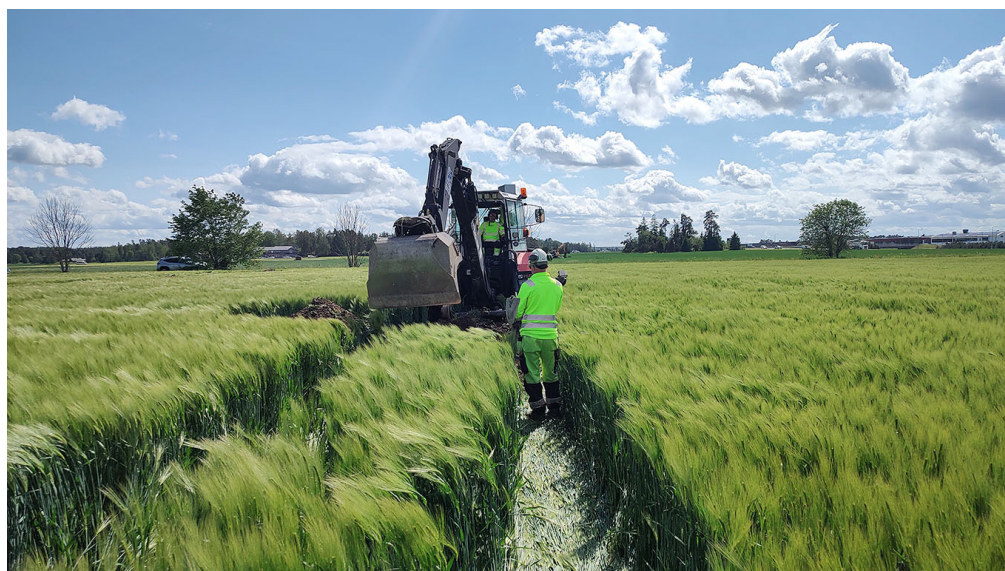
FIGUR 18. Söschaktning vid arbetsyta 5. Foto mot söder: Emma Sjöling, SAU.
