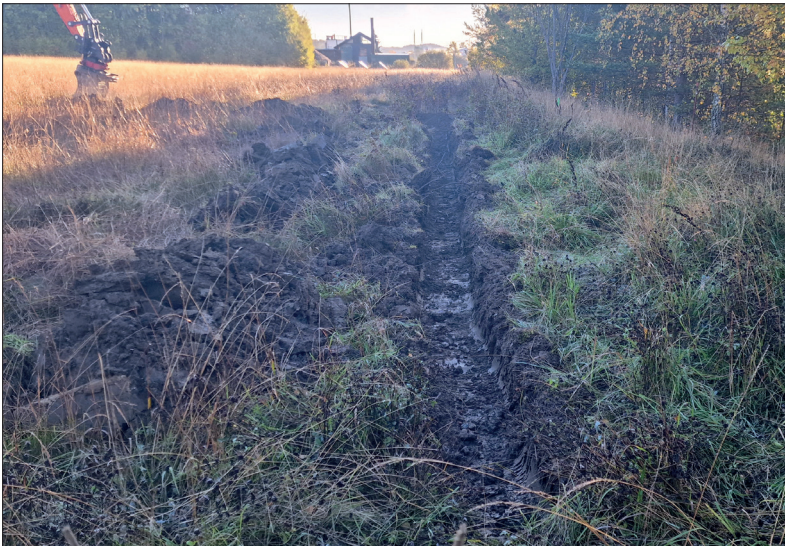
Den öst-västliga delen av schaktet. Foto mot öster: Lars Norberg 2024, Sörmlands Arkeologi AB.
