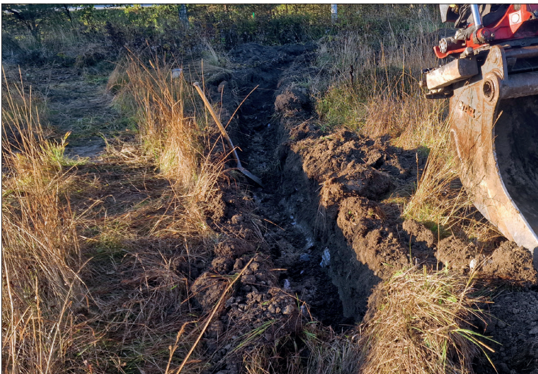
Den norra delen av schaktet. Foto mot söder: Lars Norberg 2024, Sörmlands Arkeologi AB.
