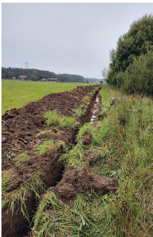
FIGUR 4. Schaktet längs Åsbyggebäcken inom delområde 1. Foto mot nordväst: Fredrik Andersson, SAU.
