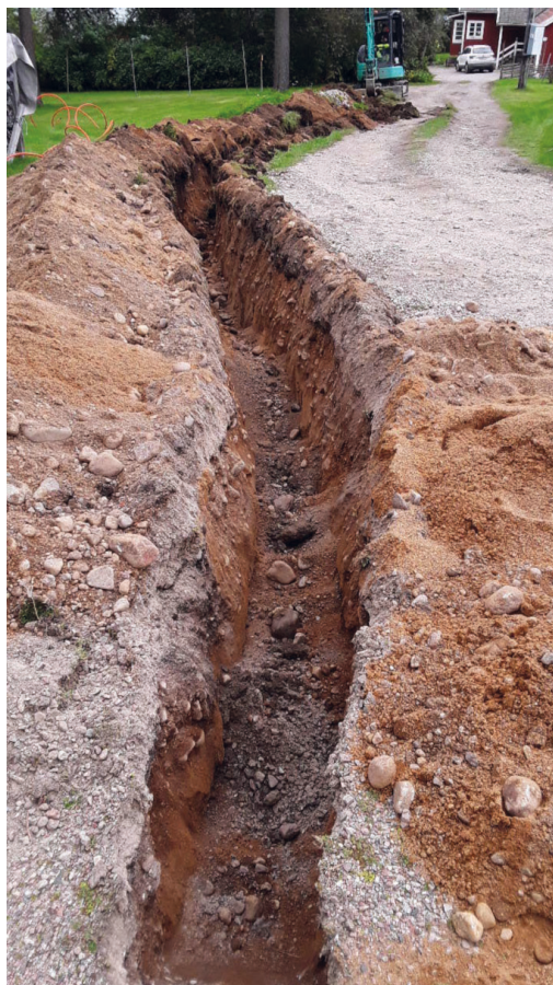
FIGUR 10. Schakt S1004 löpte längs med en grusväg inom delområde 4. Foto mot söder: Lars Sundström, SAU.
