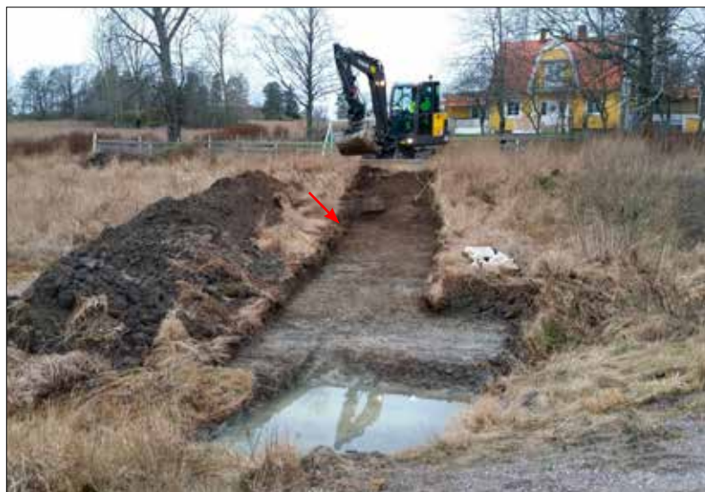
Schakt 3 fotograferat mot väster. Pilen markerar ungefärligt läge för A5 (nästa foto, medan grävmaskinen står på en del av den äldre vägsträckningen (A6). Foto: Lars Norberg 2020, Sörmlands Arkeologi AB.
