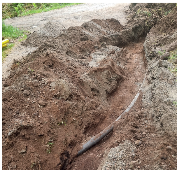
Figur 7. Schakt 15 där äldre ledning påträffades vid schaktningen. Foto: Astrid Lennblad
