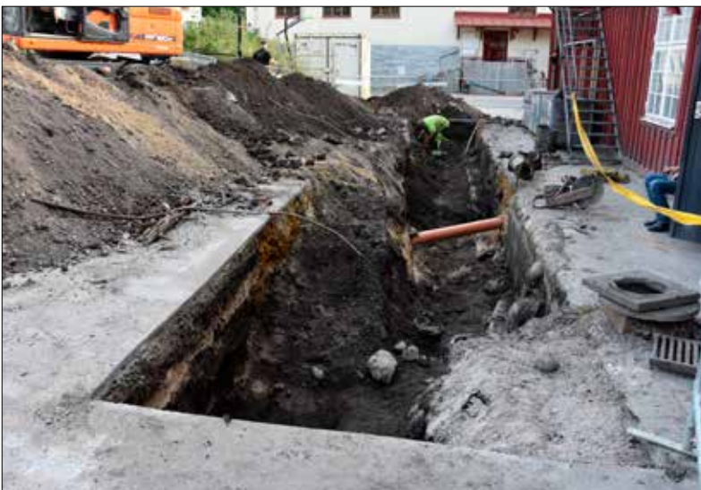
Schaktning dag 1, mot söder. Foto: Lars Norberg 2016, Sörmlands Arkeologi AB.
