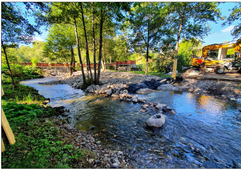
Arbetsbild nedströms dämnet. Till höger syns arbetsfordon som står på stockmattor. Bilden är tagen från sydöst. Foto: Patrik Gustafsson Gillbrand 2022, Sörmlands Arkeologi AB.
