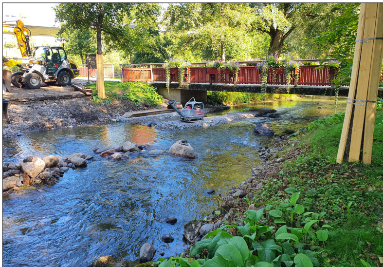
Arbetsbild nedströms dämnet. Grusmaterial som paddas. Bilden är tagen från sydväst. Foto: Patrik Gustafsson Gillbrand 2022, Sörmlands Arkeologi AB.
