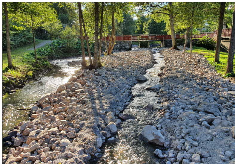
Slutresultat med utlagd grus och sten nedströms dämmet. Bilden är tagen från östsydöst. Foto: Patrik Gustafsson Gillbrand 2022, Sörmlands Arkeologi AB.
