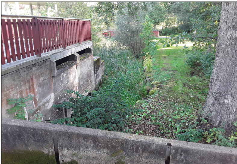
Till vänster skimtar det före detta turbinhuset. I mitten syns en med sten förstärkt kanalsida nedströms dämmet innan arbetet påbörjades. Bilden är tagen från västsydväst. Foto: Patrik Gustafsson Gillbrand 2022, Sörmlands Arkeologi AB.
