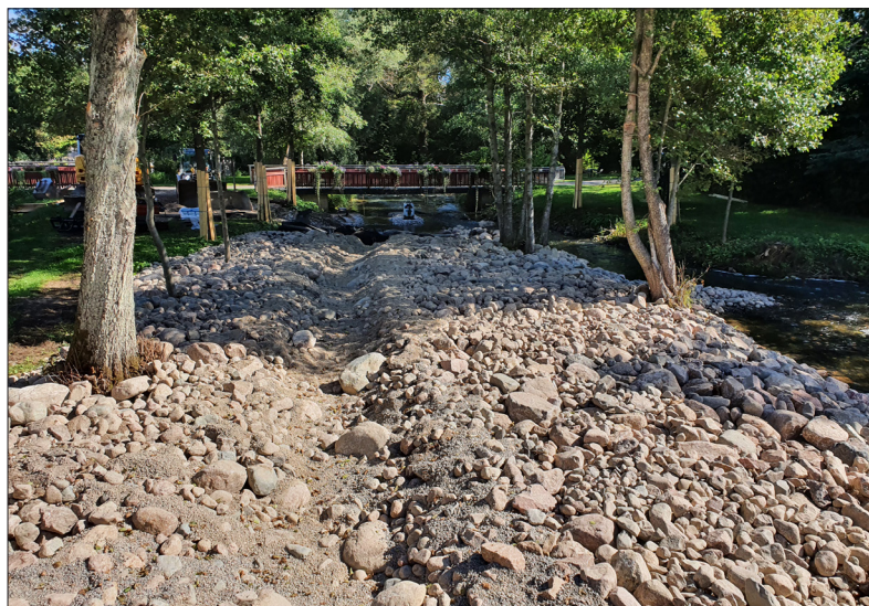
Grus och sten som lagts ut i ån nedströms dämnet. Bilden är tagen från östsydöst. Foto: Patrik Gustafsson Gillbrand 2022, Sörmlands Arkeologi AB.
