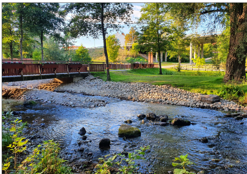
Slutresultat nedströms dämmet och bron. Bilden är tagen från sydöst Foto: Patrik Gustafsson Gillbrand 2022, Sörmlands Arkeologi AB.
