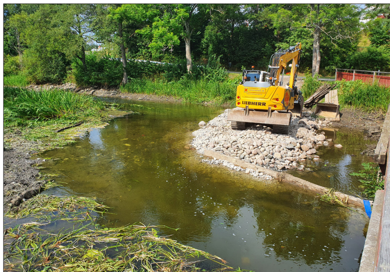
Arbetsbild uppströms dämnet. Utläggning av grus och sten. Bilden är tagen från sydsydväst. Foto: Patrik Gustafsson Gillbrand 2022, Sörmlands Arkeologi AB.
