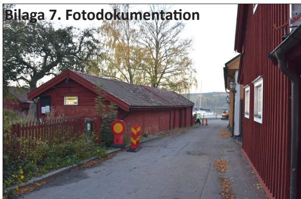
Kyrkogatan & den rötskadade bodlängan före schaktning. Foto mot söder: Lars Norberg 2018, Sörmlands Arkeologi AB.
