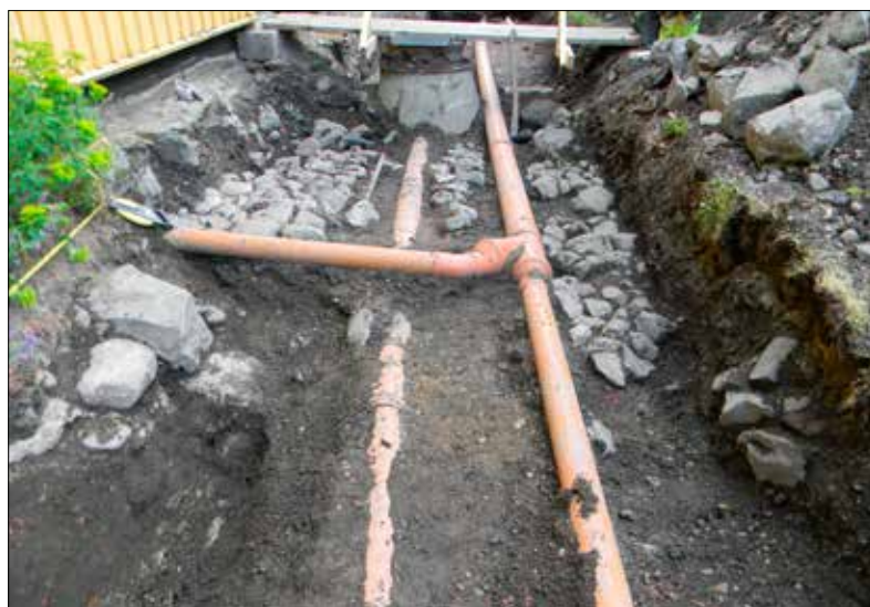
Figur 8. Den identifierade bebyggelselämningen (A2) i schaktet som resterna efter Klockargården från sent 1700-tal. Närmast i bild kan man se rester efter syllstenar och därbakom en kullerstensläggning som utgjort ett golv. Bilden är tagen från väster. Foto: Patrik Gustafsson Gillbrand 2015, Sörmlands Arkeologi AB.
