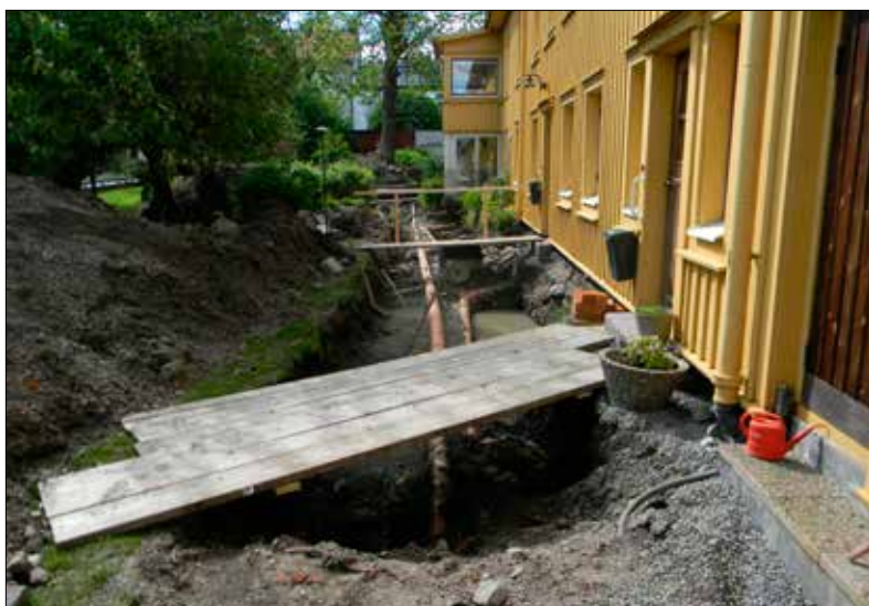
Figur 6. Förundersökningsschaktet togs upp längs med en befintlig byggnad. Notera VA-ledningarna. Bilden är tagen från öster. Foto: Patrik Gustafsson Gillbrand 2015, Sörmlands Arkeologi AB.
