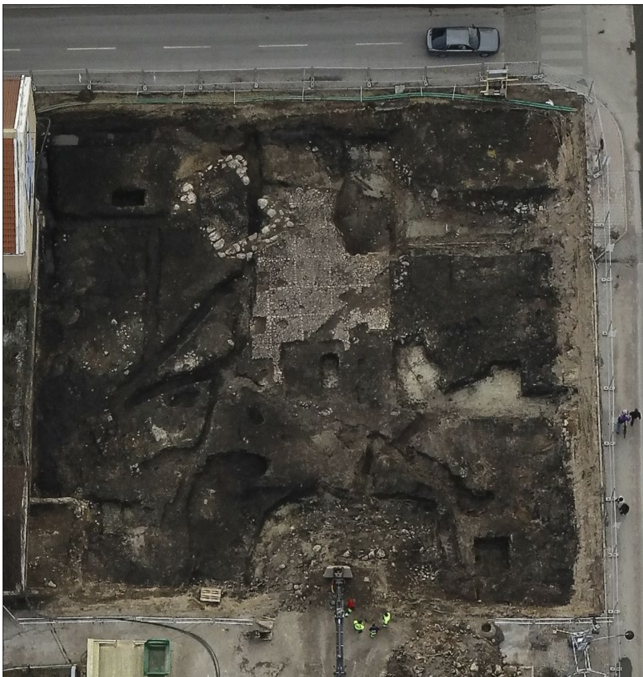
Figur 105. Flygfoto över Åkroken 3 efter schaktning. På fotot syns den yngsta torgbeläggningen (KG1003), och husgrunden (KG1002). Foto: Hawkeye.
