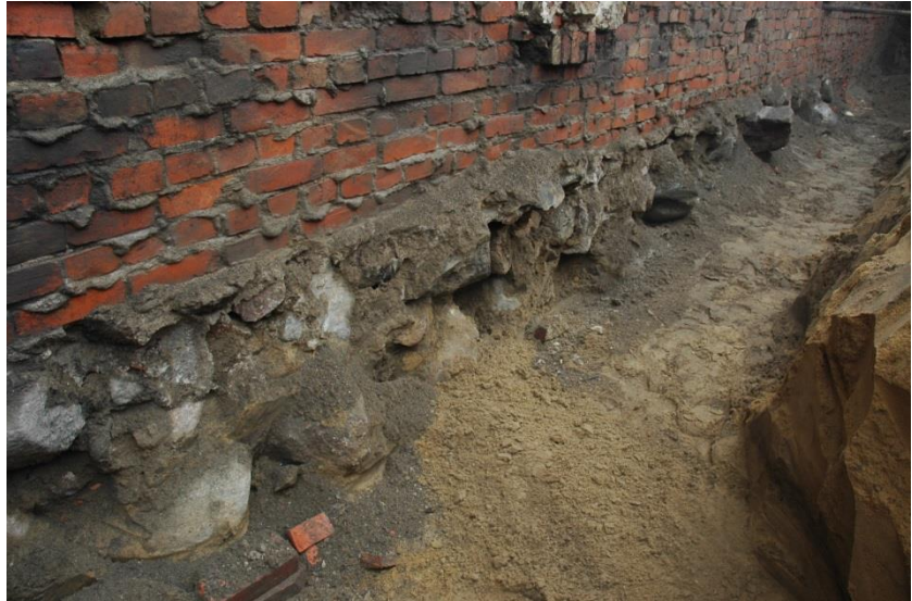
Figur 4. Del av grundmuren.
