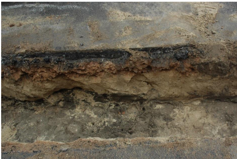
Figur 6. Schakt ute i Sjögatan, sektion mot söder.
