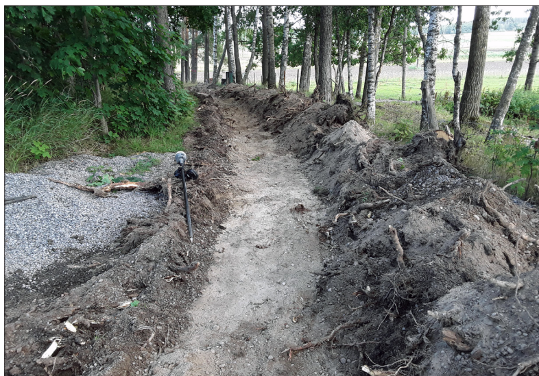
Schakt 4 för VA ledning. Bilden är tagen från S. Foto: Ingeborg Svensson 2020, Sörmlands Arkeologi AB.
