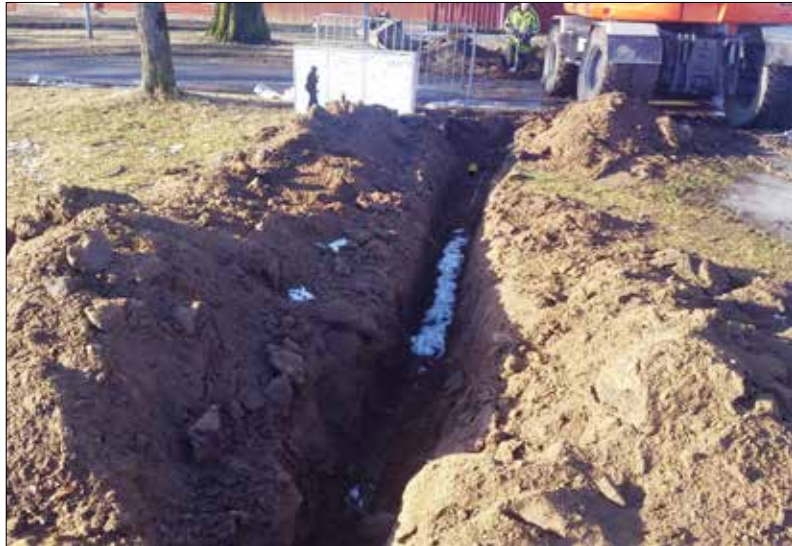
Figur 7. Detalj av den öppna schaktsträckan. Bilden är tagen från öster. Foto: Patrik Gustafsson Gillbrand 2017, Sörmlands Arkeologi AB.
