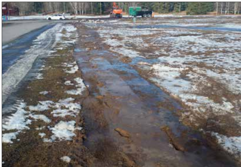
Figur 9. Detalj av det igenlagda ledningschaktet. Notera lervällningen. Bilden är tagen från söder. Foto: Patrik Gustafsson Gillbrand 2017, Sörmlands Arkeologi AB.
