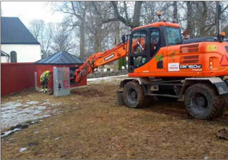
Figur 1. Översikt över den nordvästra delen av det planerade ledningsschaktet inför schaktning. Bilden är tagen från sydöst. Foto: Patrik Gustafsson Gillbrand 2017, Sörmlands Arkeologi AB.
