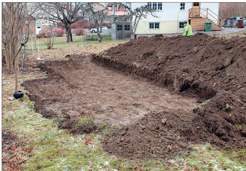
Schakt 130. Foto mot norr: Lars Norberg 2021, Sörmlands Arkeologi AB.
