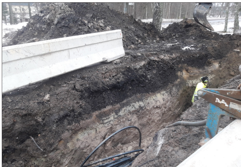
Figur 2. Situationsbild över VA-schakt med ett väl synligt svart slagglager i schaktväggen (schakt 1). Bilden är tagen från sydöst. Foto: Patrik Gustafsson Gillbrand 2019, Sörmlands Arkeologi AB.
