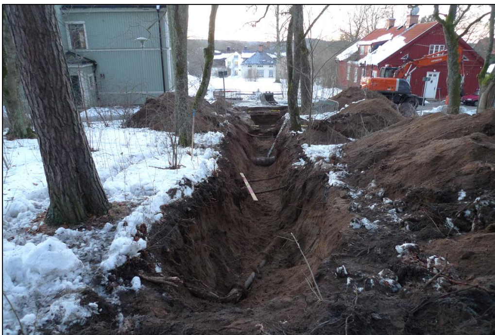
Figur 3. Den södra delen av schaktet innan det nya avloppsröret har anslutits. Notera att det gamla röret har en annan sträckning än det nya schaktet. Mot söder. Foto Jonas Svensson Hennius.
