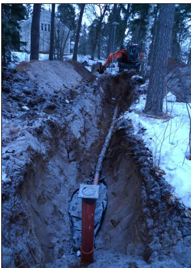
Figur 6. Den norra delen av röret som alltså grävdes efter att den södra delen av schaktet hade fyllts igen. Mot norr. Foto: Jonas Svensson Hennius.
