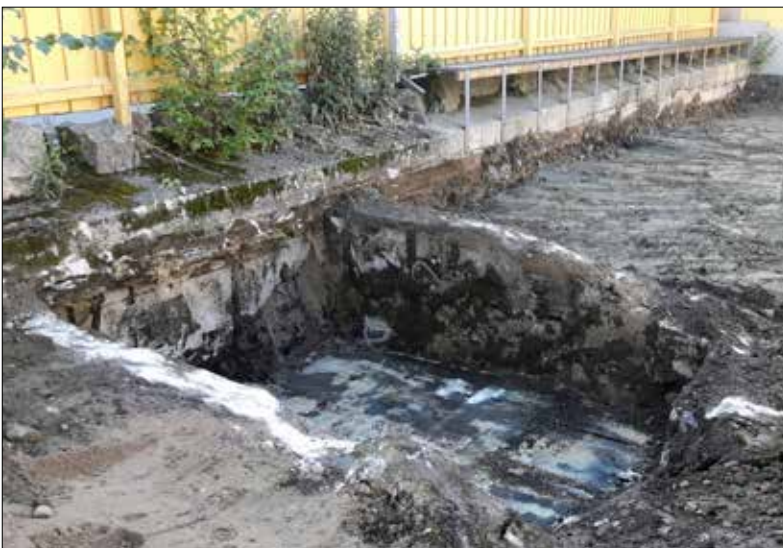
Betongkällaren inom yta 1. Foto mot söder: Lars Norberg 2017, Sörmlands Arkeologi AB.
