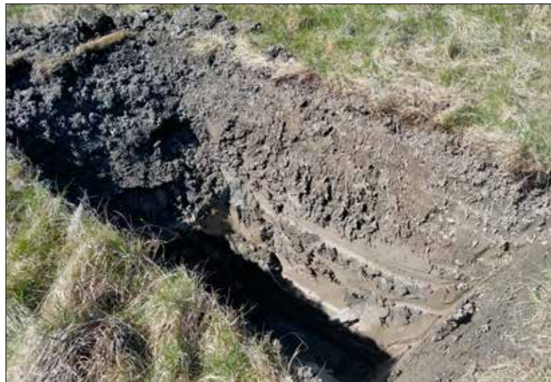
Schakt 1 som grävdes inför uppförandet av en ny luftledningsstolpe. Foto från nordöst: Patrik Gustafsson Gillbrand 2017, Sörmlands Arkeologi AB.
