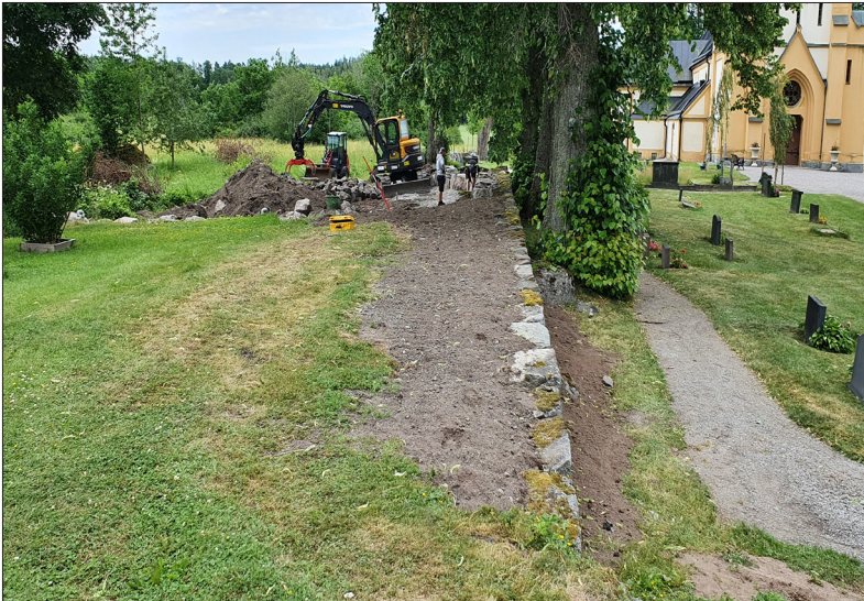
Det norra murpartiet mot öster under renovering. I bakgrunden Helgarö kyrka. Foto: Lars Norberg 2021, Sörmlands Arkeologi AB.
