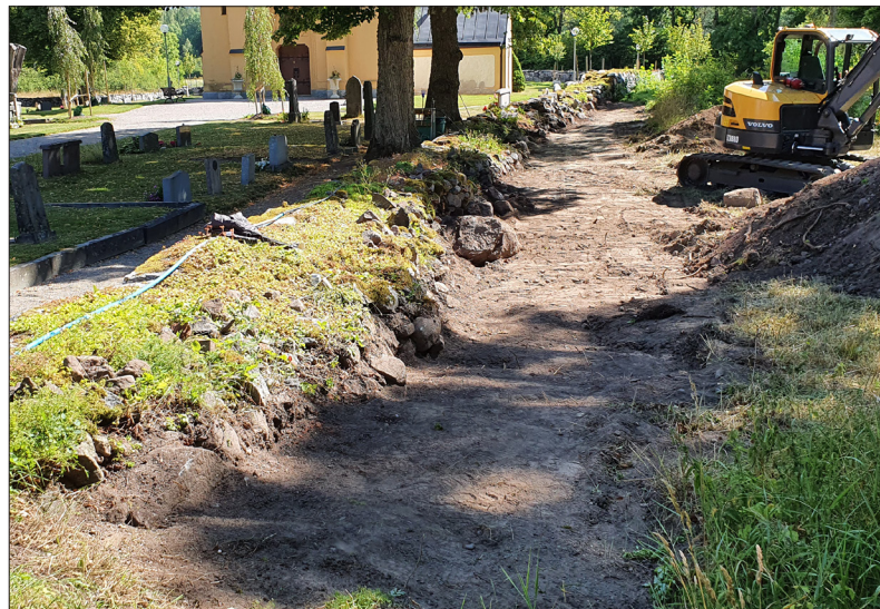
Schakt 1 & södra murpartiet mot sydost före renovering. I bakgrunden Helgarö kyrka. Foto: Lars Norberg 2020, Sörmlands Arkeologi AB.
