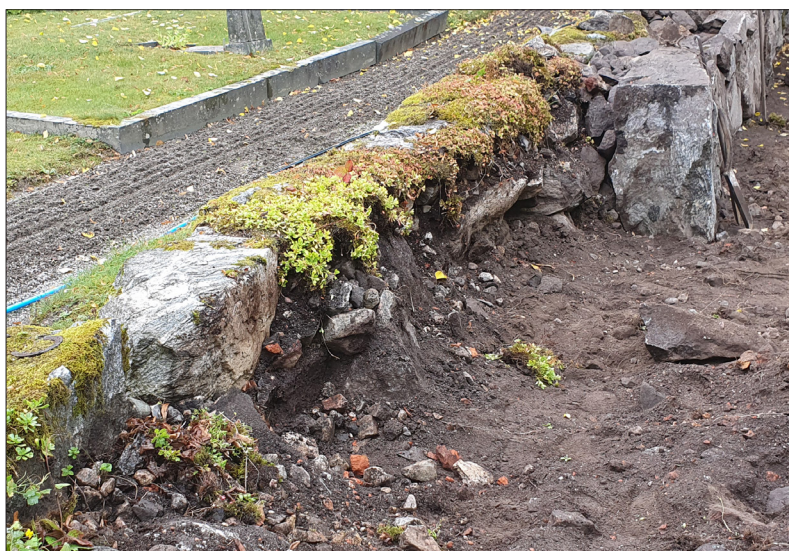
Del av den södra mursträckningen i samband med rivning. Notera teglet i rasmassorna. Foto mot öster: Lars Norberg 2020, Sörmlands Arkeologi AB.
