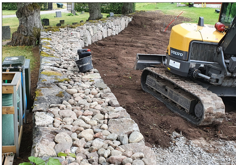
Återställning av markytor intill den norra mursträckningen. Foto mot väster: Lars Norberg 2021, Sörmlands Arkeologi AB.
