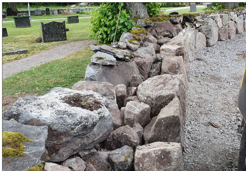
Del av den norra mursträckningen i samband med rivning. Foto mot väster: Lars Norberg 2021, Sörmlands Arkeologi AB.
