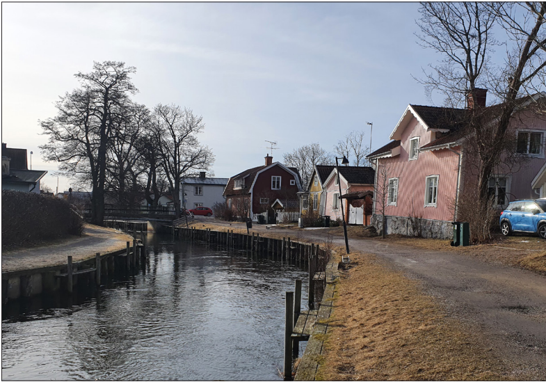
Översikt mot norra delen av arbetsområdet samt den gamla strandskoningen till höger i bild som skulle bytas ut. Bilden är tagen från norr. Foto: Lars Norberg 2022, Sörmlands Arkeologi AB.
