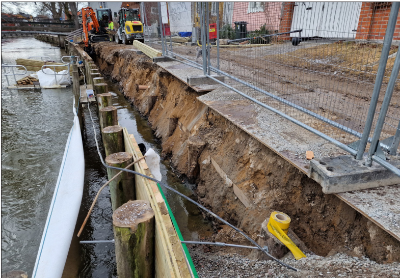
Situationsbild från den norra delsträckan med den nya strandskoningen. Bilden är tagen från norr. Foto: Lars Norberg 2022, Sörmlands Arkeologi AB.
