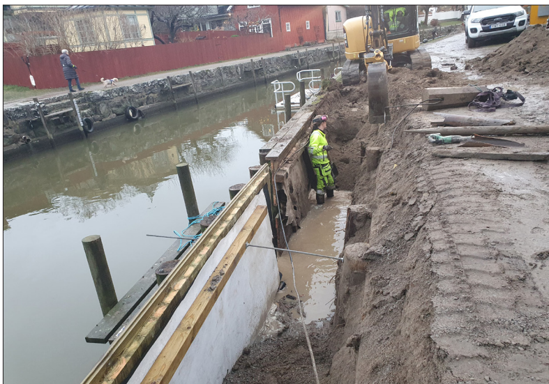
Situationsbild vid byte av strandskoning. I bilden mitt syns stockarna, stagen och skoningen tydligt. Bilden är tagen från norr. Foto: Lars Norberg 2022, Sörmlands Arkeologi AB.
