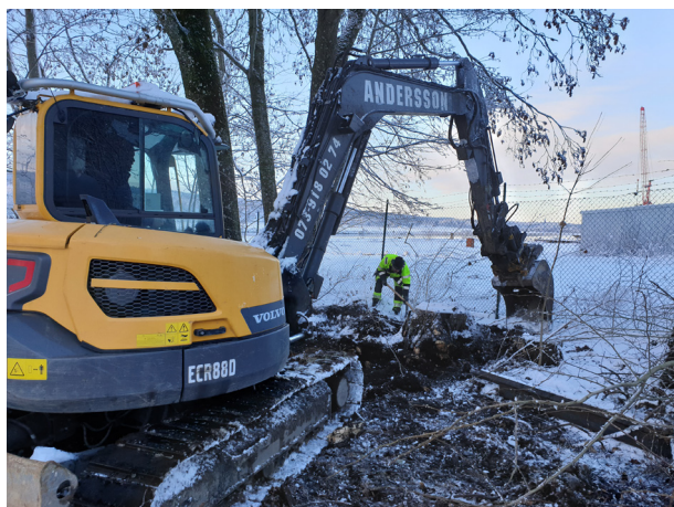
Figur 3. Schaktning i vinterlandskap. Foto: Anton Lazarides
