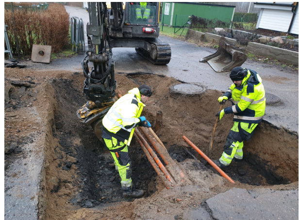
Figur 8. Schaktning i befintliga schakt.
