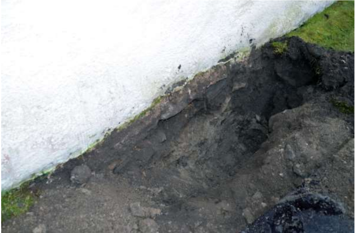
Figur 5. Schakt 3 fotograferat mot sydväst. Notera den enkla grundläggningen jämfört med den som påträffades i schakt 1. Foto: Lars Norberg 2015, Sörmlands Arkeologi AB.
