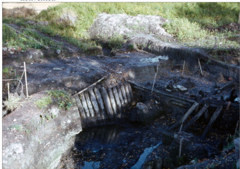
Figur 5. Foto av dammkonstruktionen intill dominikankonventet. Foto taget mot nordost, vid det sydligaste schaktet av aktuell undersökning. Foto: Lödöse museum, 1966.
