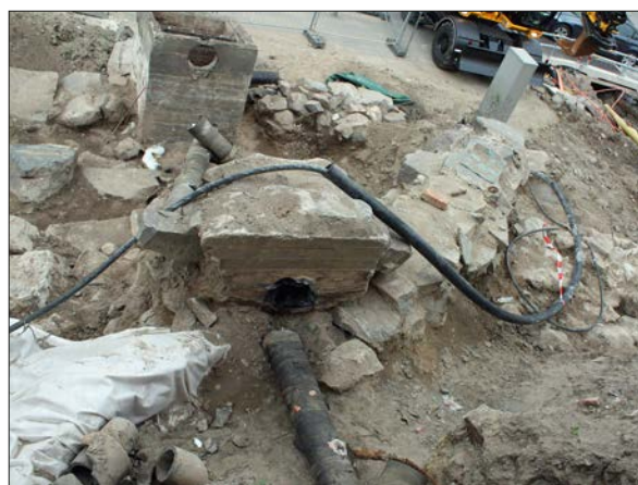
Figur 27. Fjärrvärmeledningen hade byggts genom och över flera av de äldre murarna. Foto från öster.
