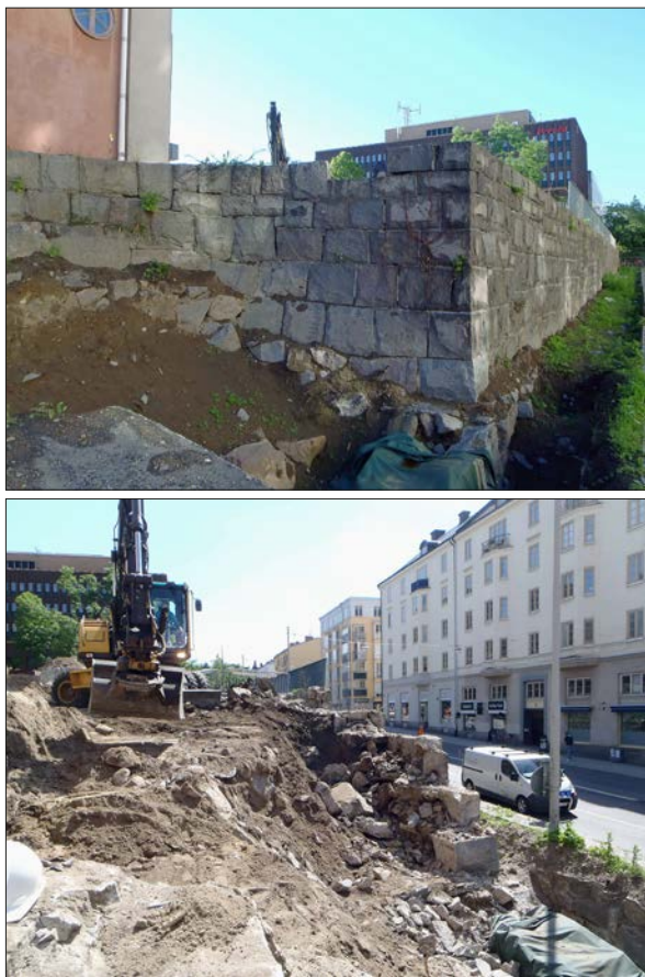
Figur 25. Stödmuren mot G:a Rådstugugatan innan och under rivning. Foto från nordväst.
