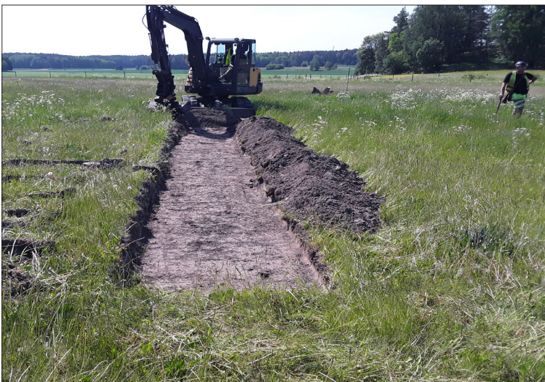
Exempel på ett av de grävda sökschakten (S2131). Bilden är tagen från N. Foto: Ingeborg Svensson 2024, Sörmlands Arkeologi AB.
