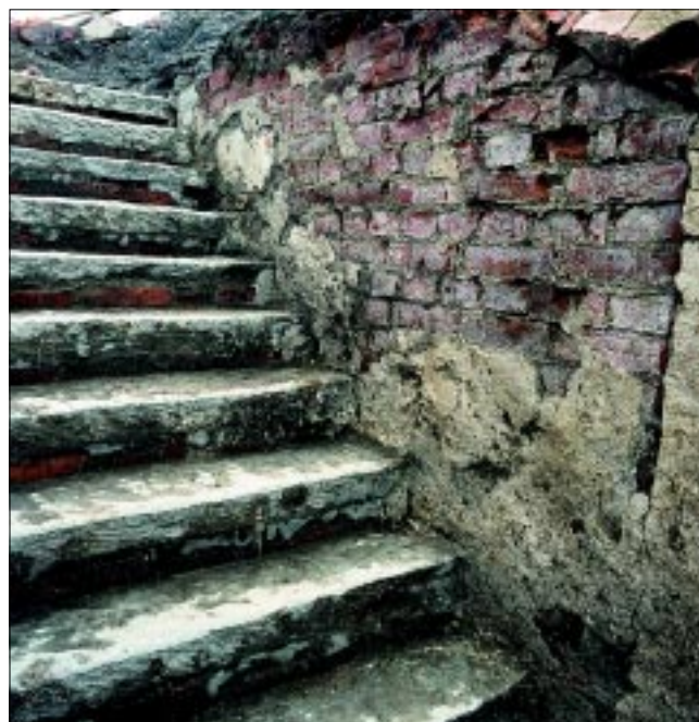
Fig 6b. Detaljfotografi av trappens södra avslut mot källaren. I högerkant syns stötfogen mellan den gamla och nya dörrposten. I övre högra hörnet syns även en av anfangsstenarna till valvet över dörren. Fotografiet taget från nordväst. Foto Håkan Ahldén.
