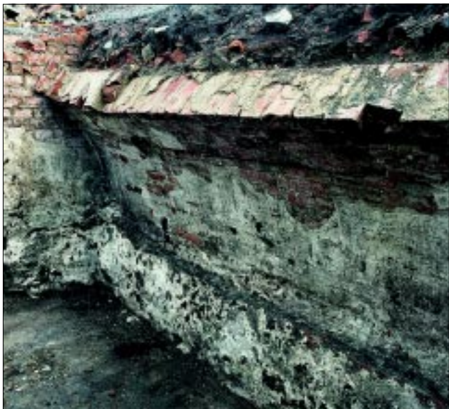
Fig 7. Fotografi av norra rummets östra långvägg och norra gavelväggen framför trappen. På bilden syns den sockel i natursten som löper längs hela väggen. Jämför även profil fig 5. Fotografiet taget från sydväst. Foto Håkan Ahldén.
