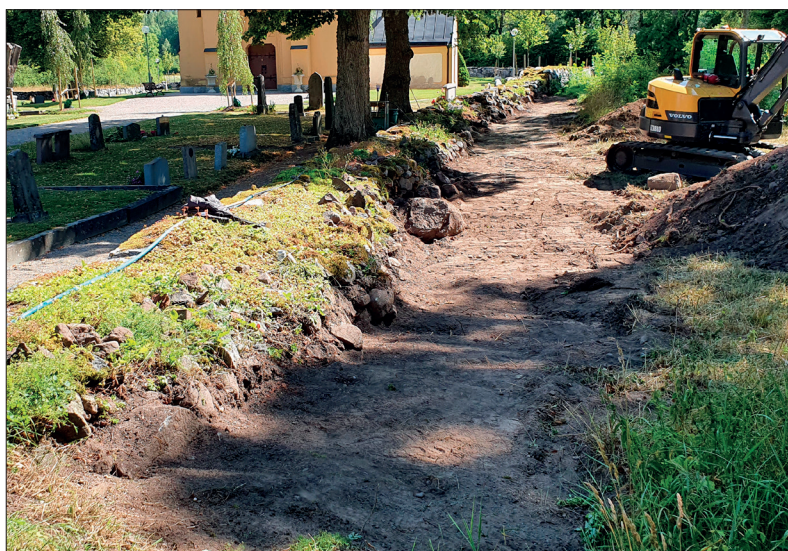
Schakt 1 & murpartiet mot sydost före renovering. I bakgrunden Helgarö kyrka. Foto: Lars Norberg 2020, Sörmlands Arkeologi AB.
