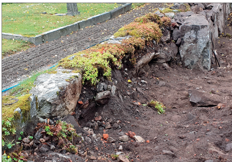
Del av mursträckningen i samband med rivning. Notera teglet i rasmassorna. Foto mot öster: Lars Norberg 2020, Sörmlands Arkeologi AB.
