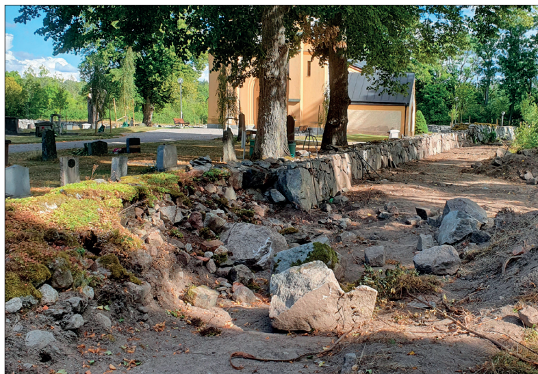
Del av mursträckningen i samband med rivning. Foto mot öster: Lars Norberg 2020, Sörmlands Arkeologi AB.
