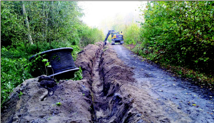
Figur 2. Arbetsbild över det öppnade kabelschaktet. Bilden är tagen från sydväst. Foto: Patrik Gustafsson Gillbrand 2015, Sörmlands Arkeologi AB.
