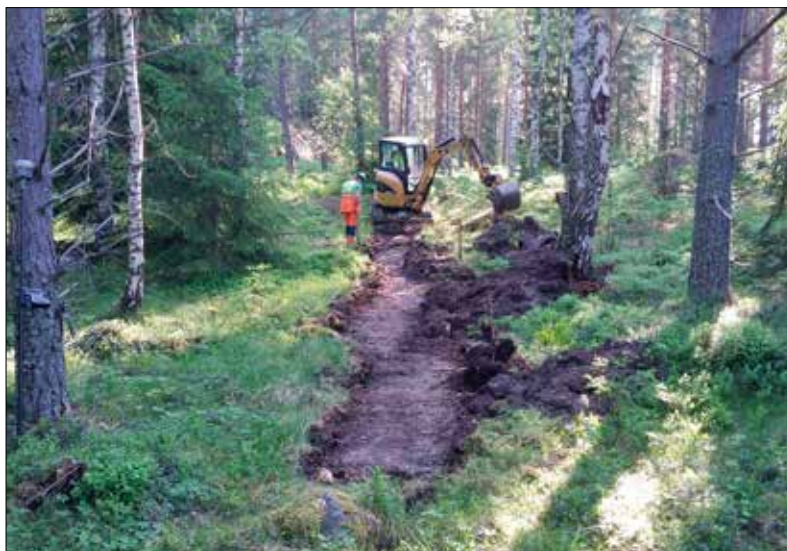
Schakt 1 inom objekt 2 fotograferat mot nordost. Foto: Lars Norberg 2016, Sörmlands Arkeologi AB.
