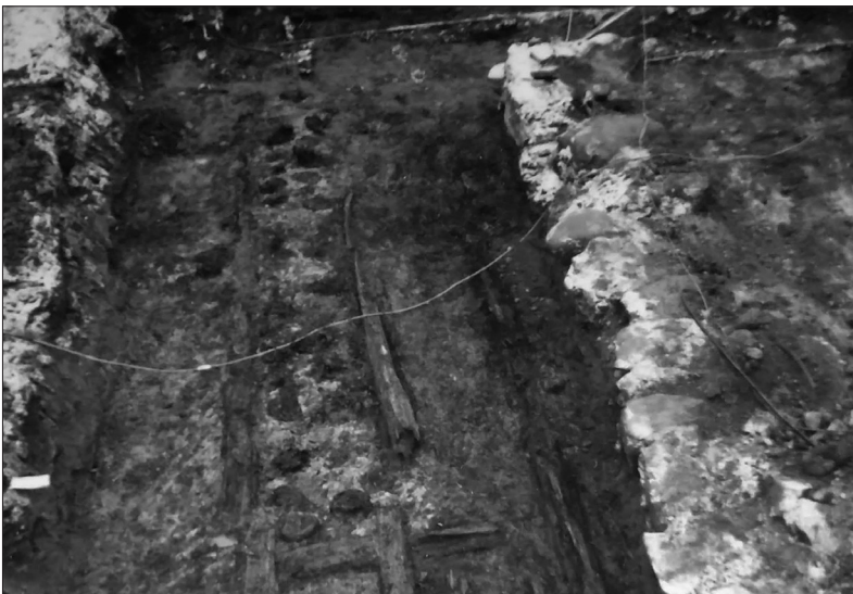
Bild nr 5. Översikt över gården till Gripsholms vårdshus (kv. Källaren). Rustbädd A9 framrensad. Från öster. Foto: ATA (Dnr 84/1988).
