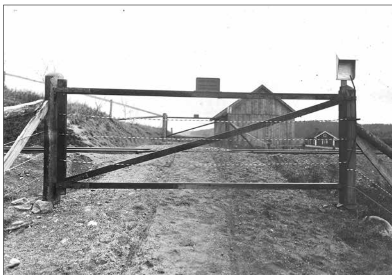
Figur 12. Exempel på en grind vid en järnvägsövergång någonstans på statsbanan Järna-Norrköping. Källa: Sveriges järnvägs-museum, KDAB01031, fototid år 1910-1932.
