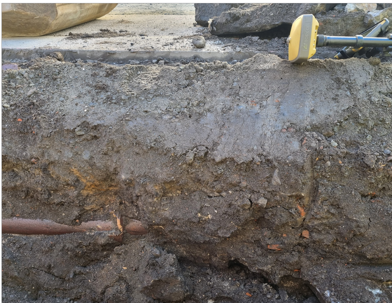
Figur 3. Foto från schakt 2 där ett höganäsrör påträffades i schaktväggen mot gatan. Foto: Astrid Lennblad
