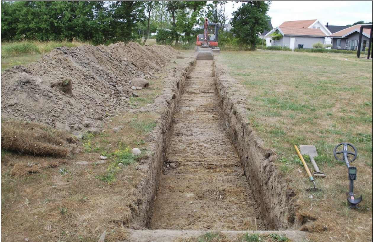
Figur 4. Schaktning pågår i schakt 1. Foto från öster: Katalin Schmidt Sabo.
