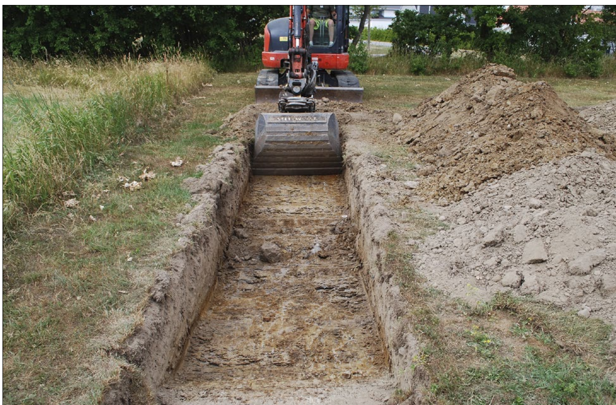
Figur 7. Schaktning pågår i schakt 3. Foto från öster: Katalin Schmidt Sabo.
