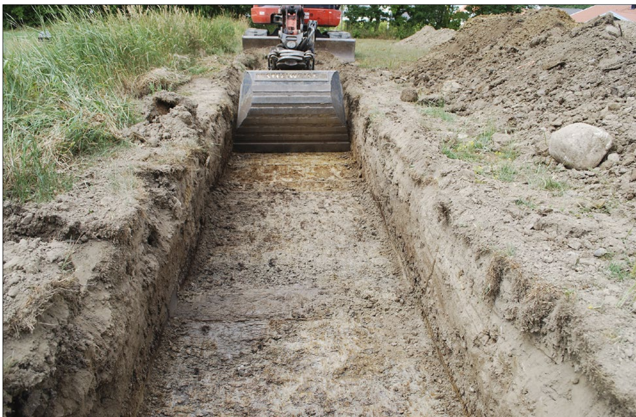
Figur 6. Schaktning pågår i schakt 2. Här syns järnutfällningarna som mörkare partier mot den sterila undergrunden. Foto från öster: Katalin Schmidt Sabo.
