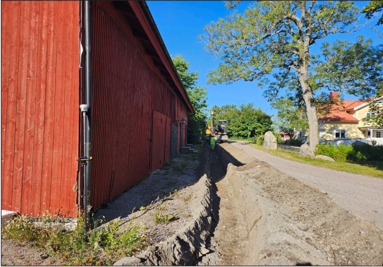
Mellersta delen av schakt 1. Foto mot väster: Lars Norberg 2026, Sörmlands Arkeologi AB.
