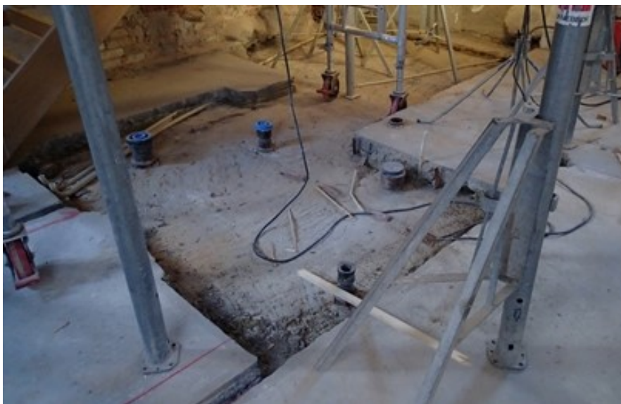
Figur 5. Schaktet för hissen i den västra delen av Latinskolan i Ystad. Foto från sydost. Foto: Björn Bjelke-Holtermann. Tyréns AB.
