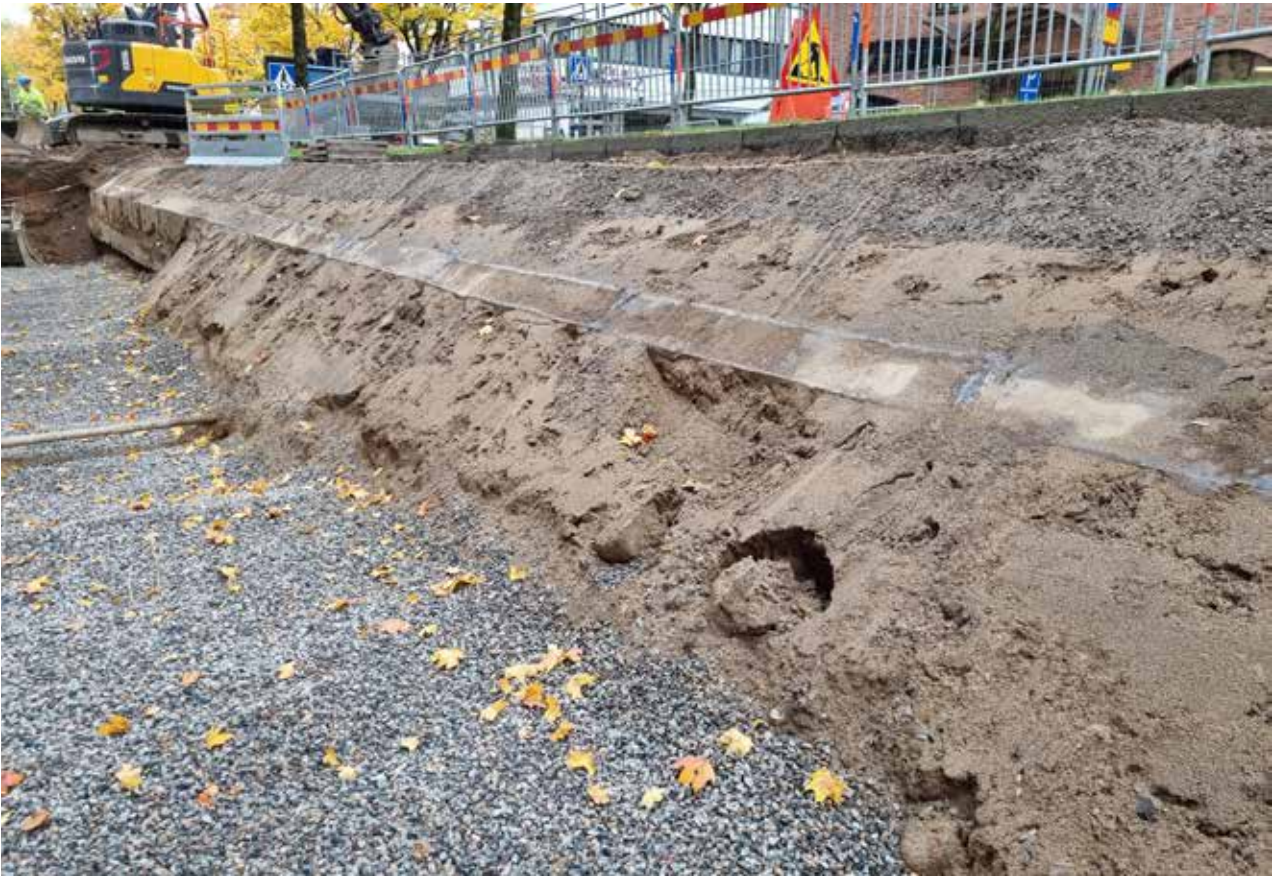
Figur 6. Betongkonstruktionen i norra schaktväggen som syns längs hela schaktets sträckning.. Foto taget från sydost. Foto: Astrid Lenblad
