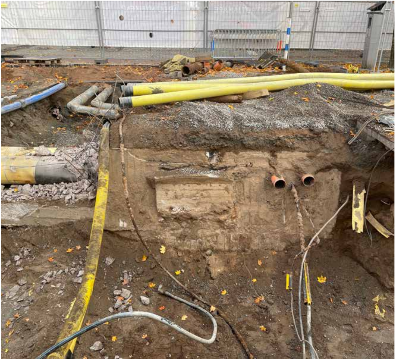
Figur 7. Det var tydligt att det aktuella arbetsföretaget utfördes inom sedan tidigare befintliga schakt. En mängd äldre ledningar, rör, sladdar och betongfundament framkom vid schaktningen. Foto taget från norr. Foto: Anna Beckman.
