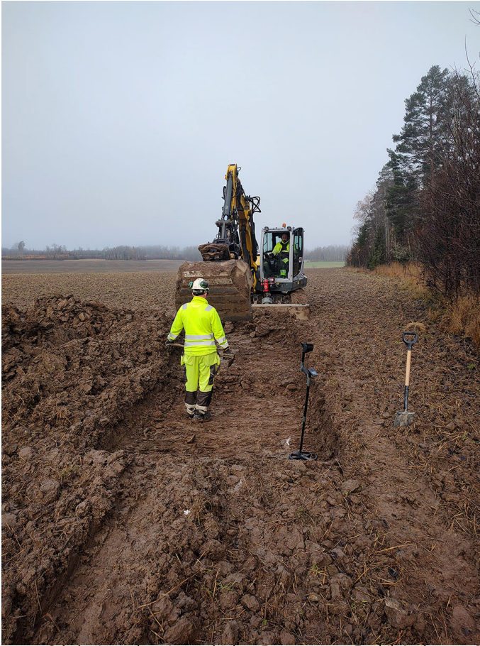
FIGUR 2. Schaktningsarbete inom objekt 4. Foto mot norr: Fredrik Andersson, SAU.
