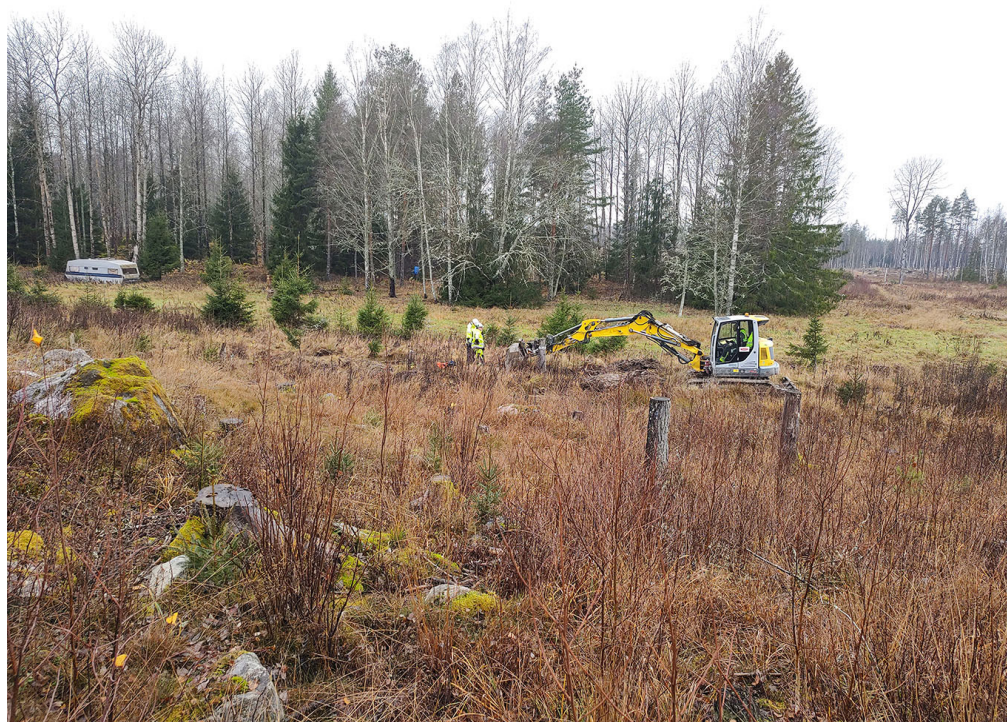
FIGUR 23. Vy över den norra delen av Objekt 7. Torplämningen L2002:5925 är belägen vid husvagnen på andra sidan ett dike. Foto mot väster: Fredrik Andersson, SAU.
