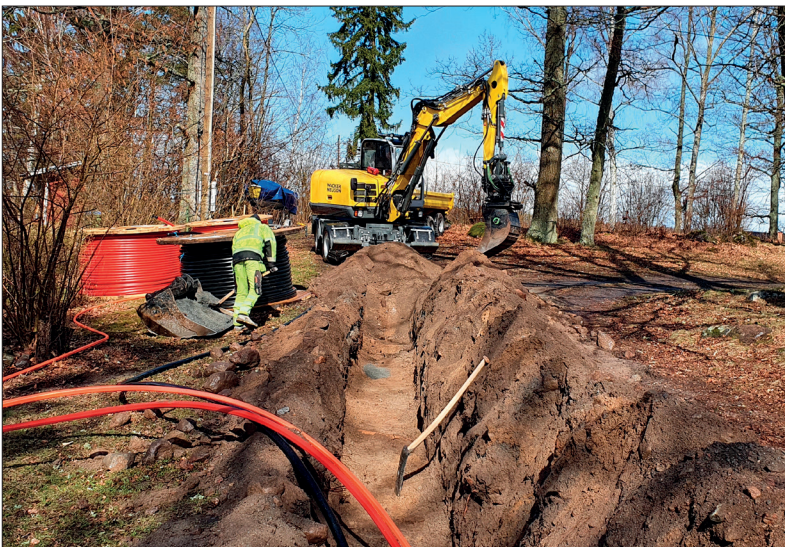
Inledande schaktning i körvägen strax söder om L1984:7916:3. Foto mot norr: Lars Nor- berg 2021, Sörmlands Arkeologi AB.
