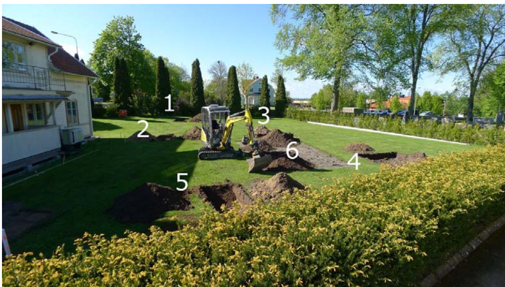
Bild 2. Översiktsfoto från den norra delen av utredningsområdet ut mot läget för ny byggnad. Numreringen i bild avser schakten (se planskiss vid sidan).
