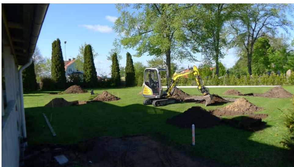
Bild 5. Foto över provschakt 6, där lagerföljden såg i stort sett ut som ovan beskrivits.
