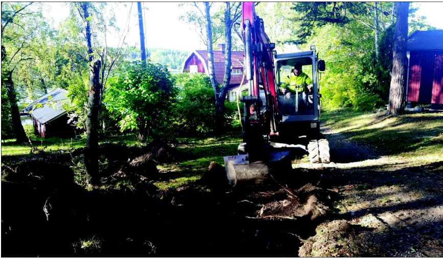
Figur 1. Under pågående schaktningsarbete. Maskinen står på den grusvägen som leder från Håstahagvägen ned till bostadshuset. Bilden är tagen från nordöst. Foto: Patrik Gustafsson Gillbrand 2015, Sörmlands Arkeologi AB.
