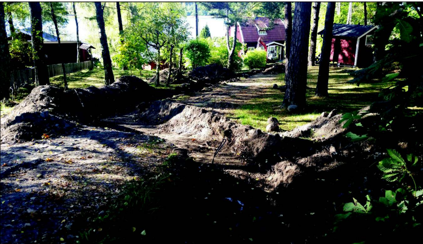
Figur 2. VA-schaktet i sin fulla längd från Håstahagvägen ned mot bostadshuset. I förgrunden syns ett uppstickande stag av järn till en numera borttagen luftledningsstolpe. Bilden är tagen från nordnordöst. Foto: Patrik Gustafsson Gillbrand 2015, Sörmlands Arkeologi AB.
