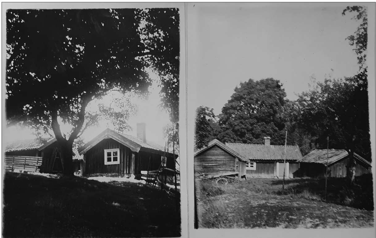
Figur 6. Fotografier av den numera rivna Ängstugan. Till vänster är bilden tagen från nordväst och till höger från öster. Fotograf: Erik Segelberg 1938. SMA. SLM-samling: Länsveterinären Torsten Segelberg och hans familj i Nyköping.
