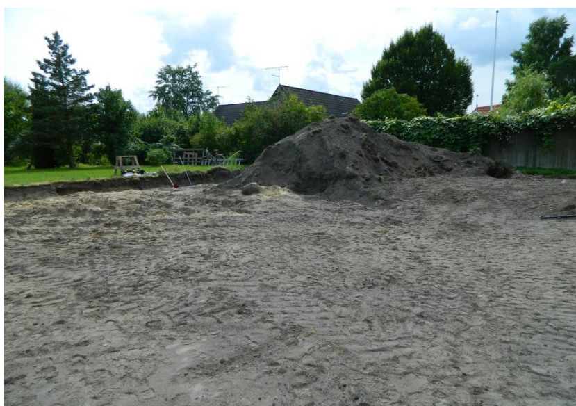
Fig. 3. Området med spårefter grävmaskin.
